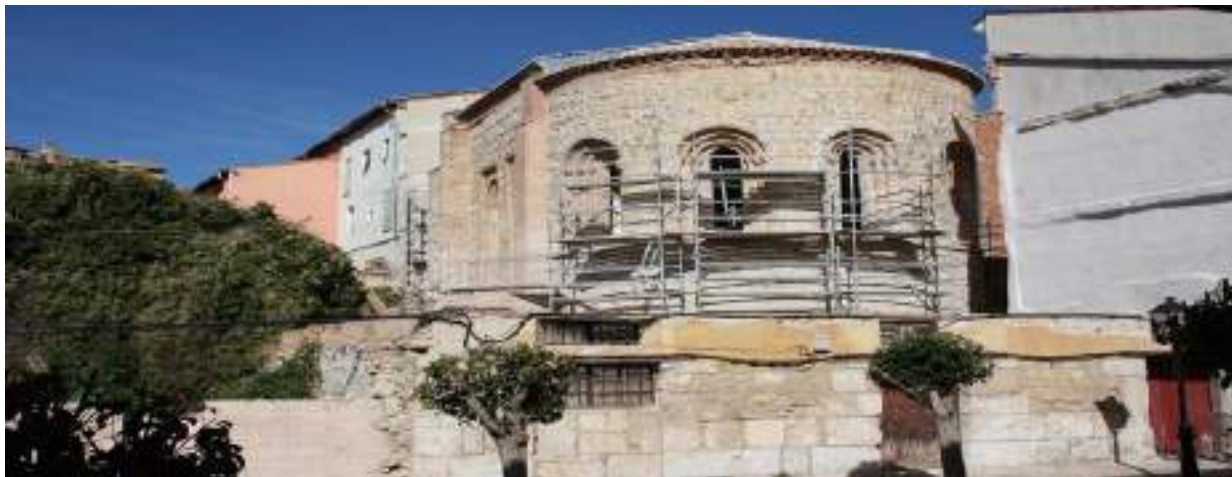
Detalle de la rehabilitación de la sinagoga medieval en Brihuega
